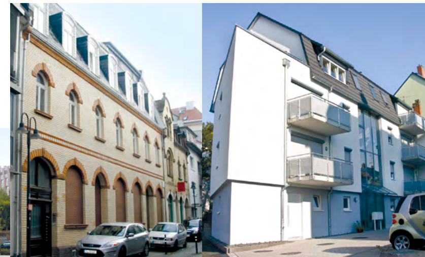
Sanierungsobjekt Wetzsteinstraße 6 in Gießen
